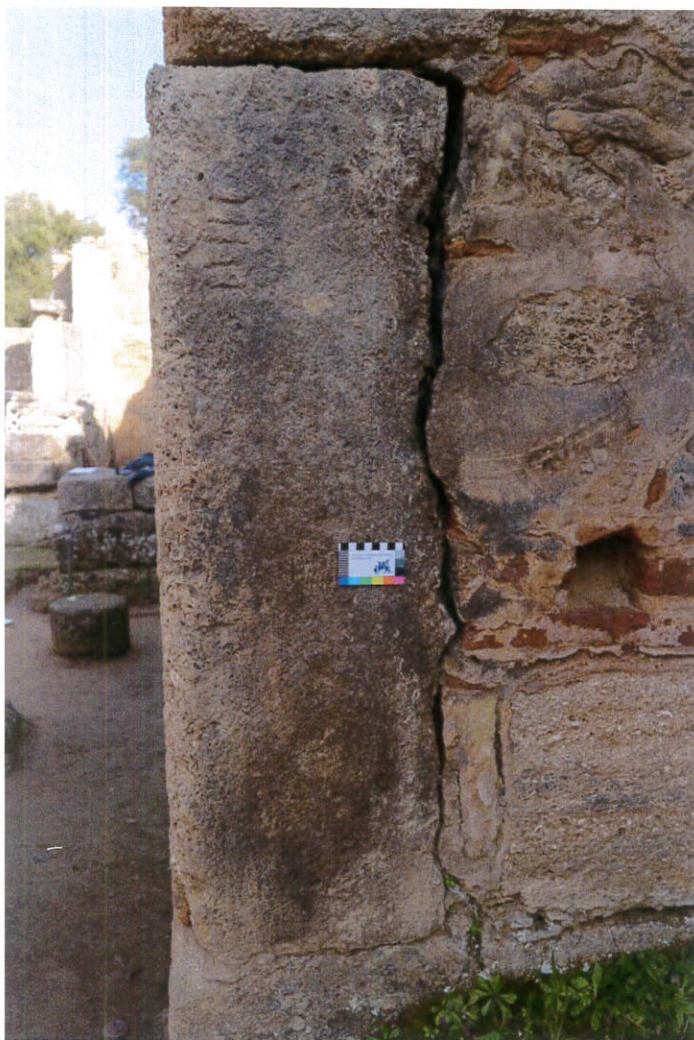
Εικ.26 (αριστερά) Αποκόλληση λίθου λόγω υποχώρησης θεμελίου Εικ.27 (δεξιά) Πρόχειρα αναστηλωμένοι σφόνδυλοι κλασικών κιόνων σε θέση πτώσης (DAI ATHEN)
