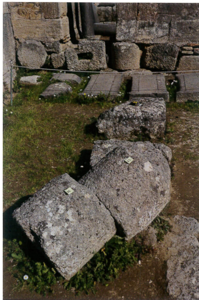
Εικ.26 (αριστερά) Αποκόλληση λίθου λόγω υποχώρησης θεμελίου Εικ.27 (δεξιά) Πρόχειρα αναστηλωμένοι σφόνδυλοι κλασικών κιόνων σε θέση πτώσης (DAI ATHEN)
