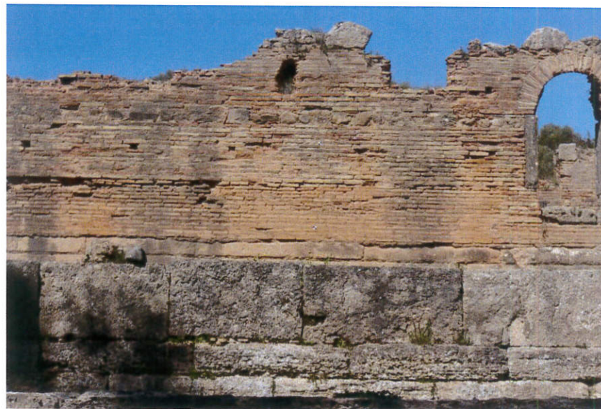
Εικ. 16 Το εργαστήριο του Φειδία. Άποψη του βόρειου τοίχου. Την ρωμαϊκή εποχή πάνω στη βάση της κλασικής φάσης χτίστηκαν νέοι τοίχοι με θώρακα από οπτοπλινθοδομή (DAI ATHEN)
